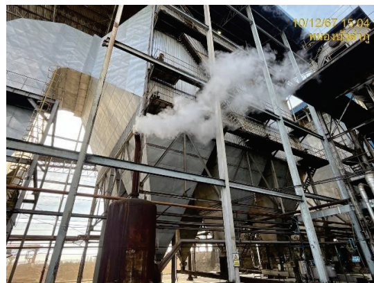
รูปที่ 1 ระบบบำบัดมลพิษอากาศจากหม้อไอน้ำแต่ละชุด แบบ Multi cyclone และแบบ ESP
