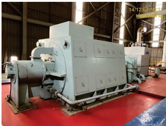
รูปที่ 48 เครื่องกำเนิดไฟฟ้ากังหันไอน้ำชุดที่ 6
