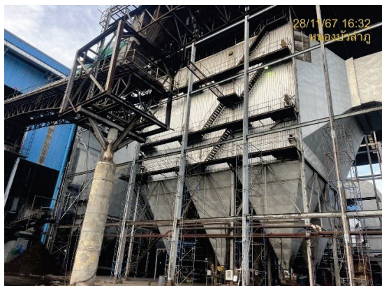
รูปที่ 1 ระบบบำบัดมลพิษอากาศจากหม้อไอน้ำแต่ละชุด แบบ Multi cyclone และแบบ ESP
