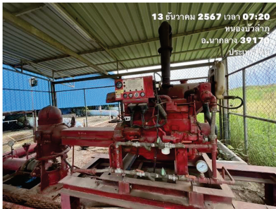
รูปที่ 52 เครื่องสูบน้ำดับเพลิงแบบดีเซล
