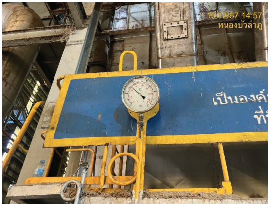
รูปที่ 43 อุปกรณ์ตรวจวัดการทำงานหม้อไอน้ำ
