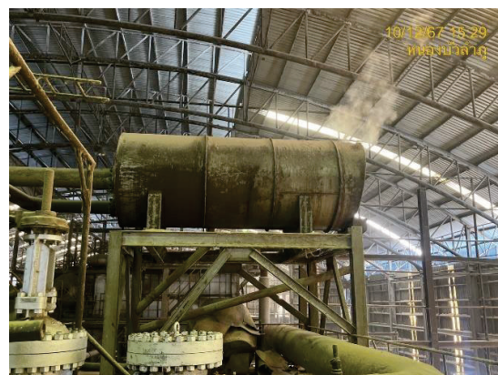
รูปที่ 51 อุปกรณ์ลดเสียง (Silencer)
